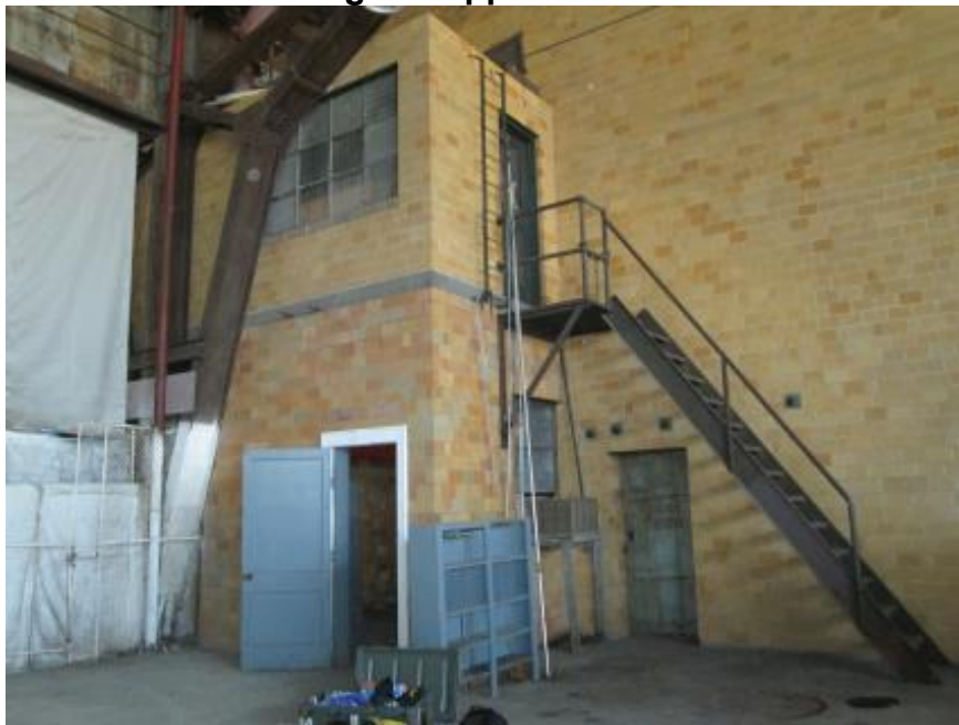
A-7. Hangar 10 Room 103 (Upper Room)
