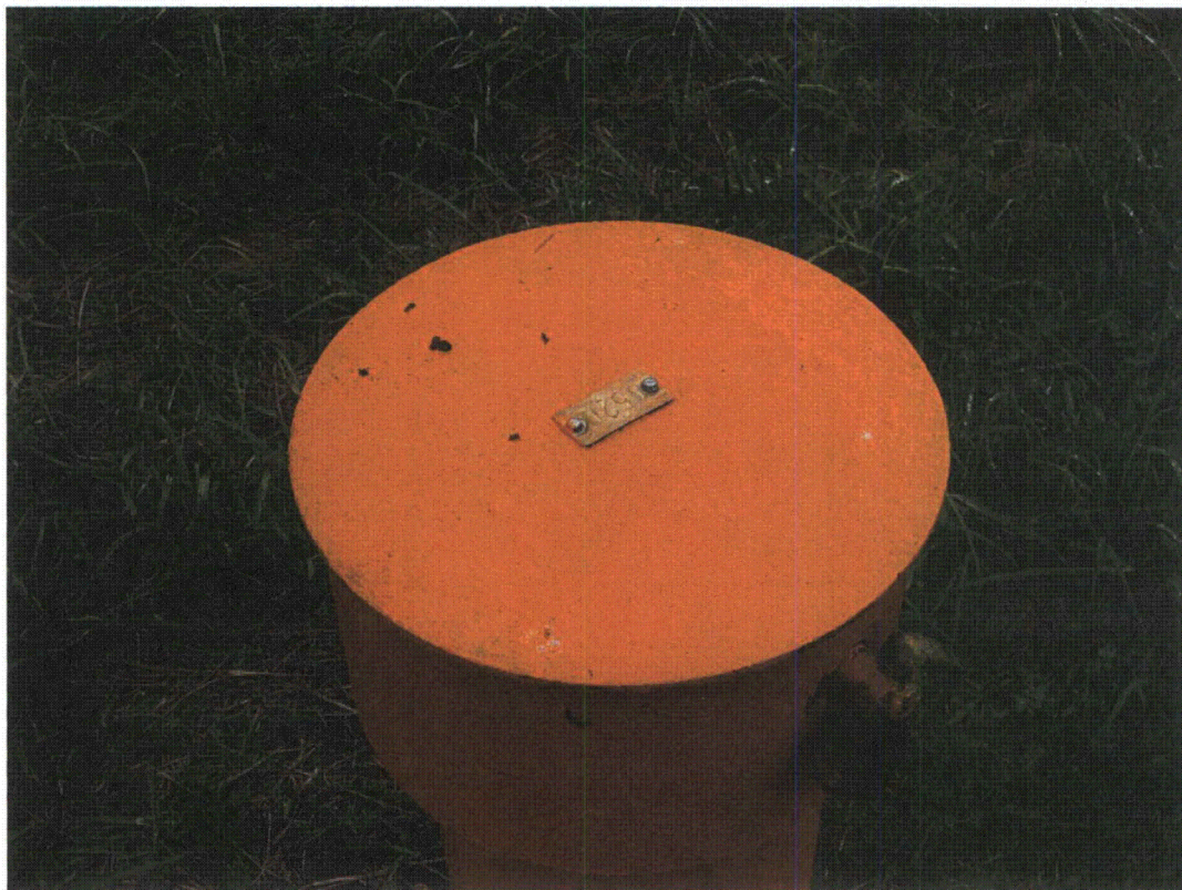
BUR 10/2011. PL-4. Brass ID tag, top of monitoring well 0520.
